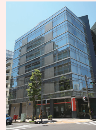
横浜市中区にある本社ビル
